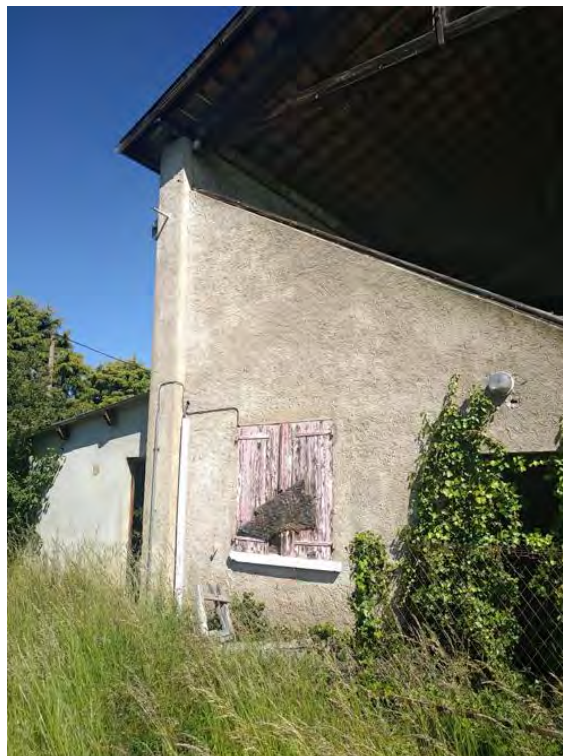
Photo 22 : bâtiment de l'ancien stade ; gîte à Chauves-souris
