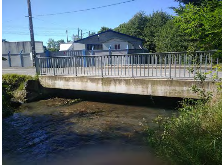
Photo 19 : ponts dalots n°5 et 7
