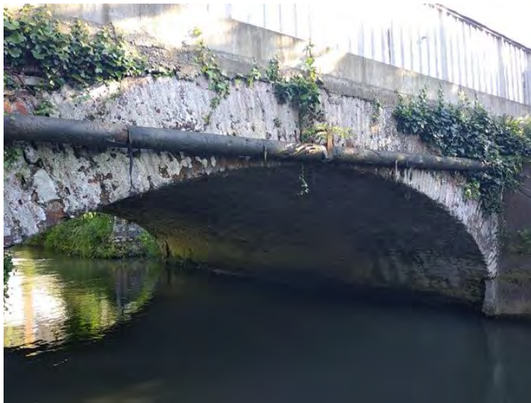
Photo 20 : voutes maçonnées n° 8 et 1
