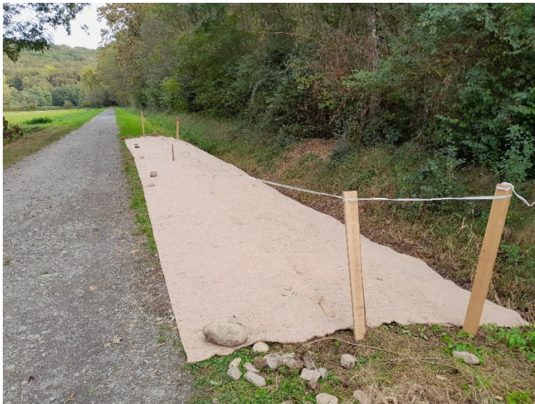
Figure 7 : Mise en place du paillage au niveau du site 2 « Bois de la Barthe ».
