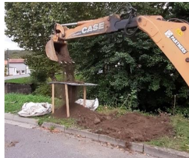
Figure 3 : Site 1 : destruction et élimination des parties racinaires par tamisage
