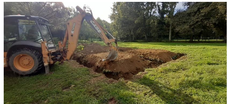
Figure 9 : Opération de creusement des tranchées inter-placettes.
