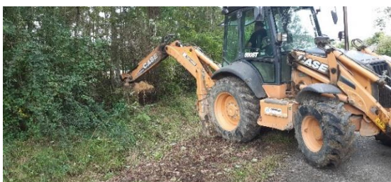
Figure 5 : Site 2 « Bois de la Barthe », destruction et retrait des plants ayant colonisés le côté opposé du fossé.
