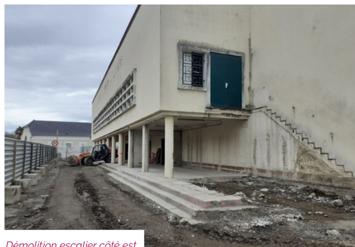
Démolition escalier côté est
