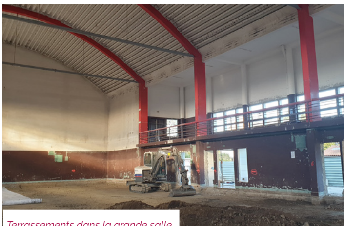
Terrassements dans la grande salle
