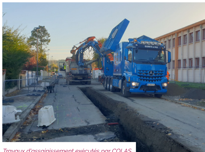
Travaux d'assainissement exécutés par COLAS
